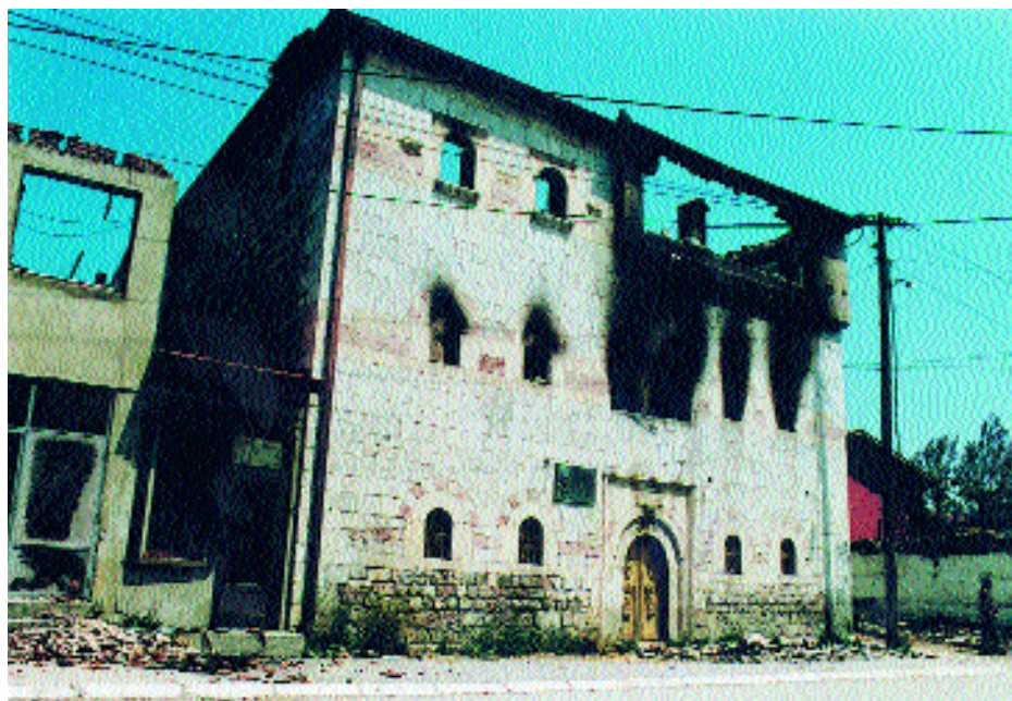
Les décombres de la kulla de Jashar Pasha construite en 1830, incendiée en mai 1999 par des Serbes.
