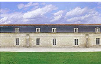
La toiture à la Mansart est composée de tuiles rondes et d'un brisis d'ardoise.
