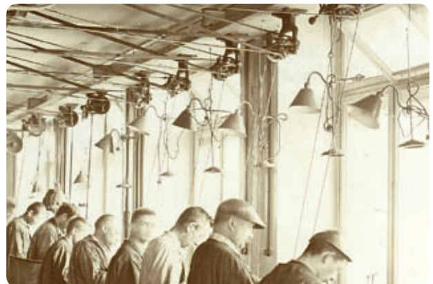
Atelier de monteurs de boîte vers 1900, transmission du mouvement cinétique par courroies.
