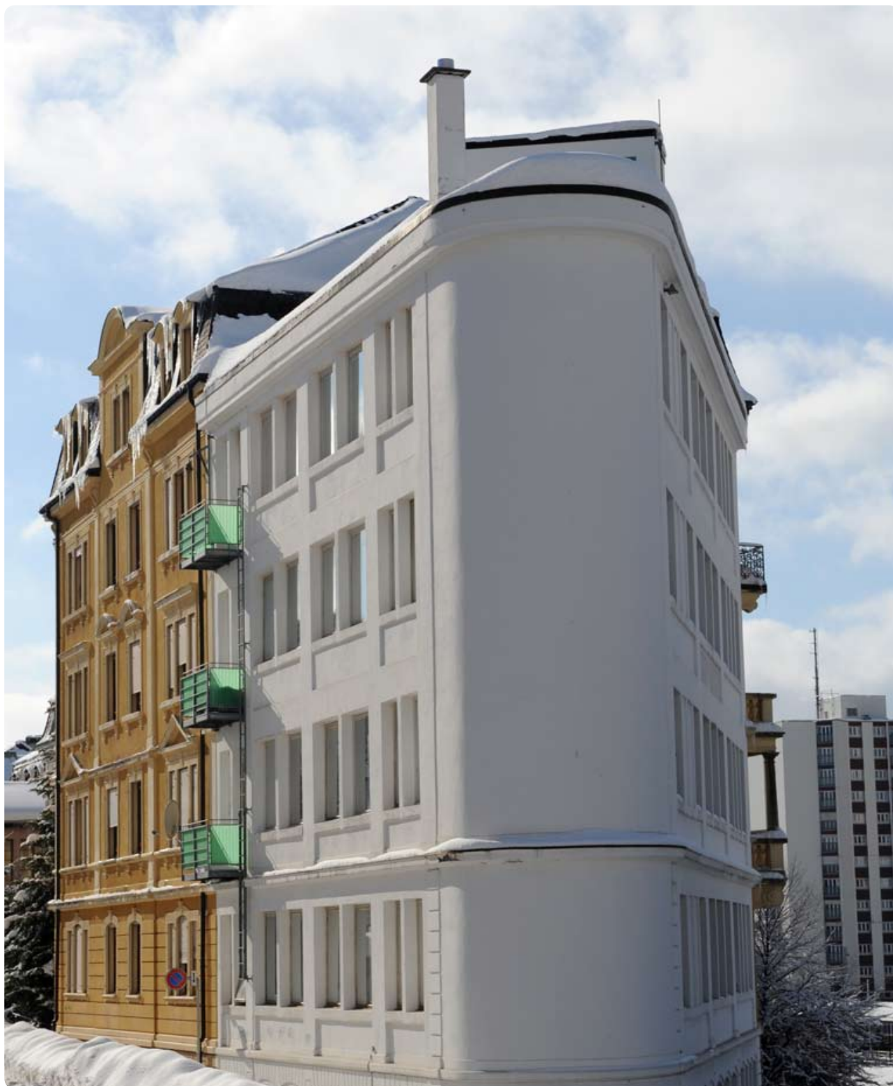
Rue des Régionaux 11, La Chaux-de-Fonds.
