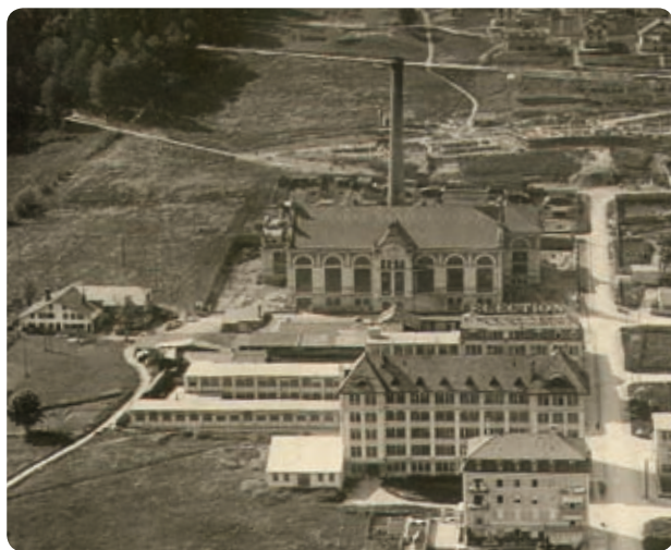
Vue aérienne de l'usine électrique et de l'usine horlogère Election (La Chaux-de-Fonds), 1925 (SUC).
